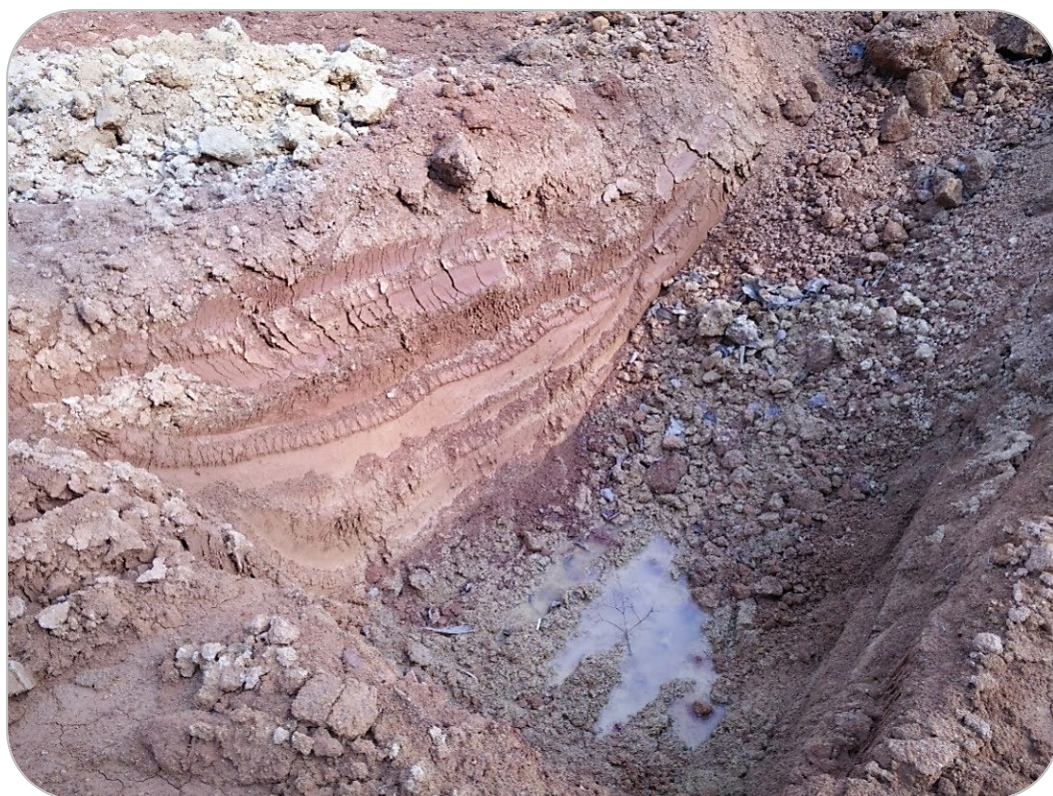
รูปที่ ๑๓ บ่อสังเกตระดับน้ำใต้ดิน กม.๑๐+๘๐๐.๐๐๐
