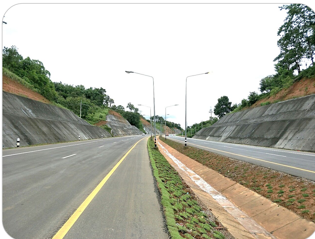
รูปที่ ๖๒ ถนนบริเวณ กม.๑๐+๘๐๐.๐๐๐ เมื่อก่อสร้างแล้วเสร็จ
