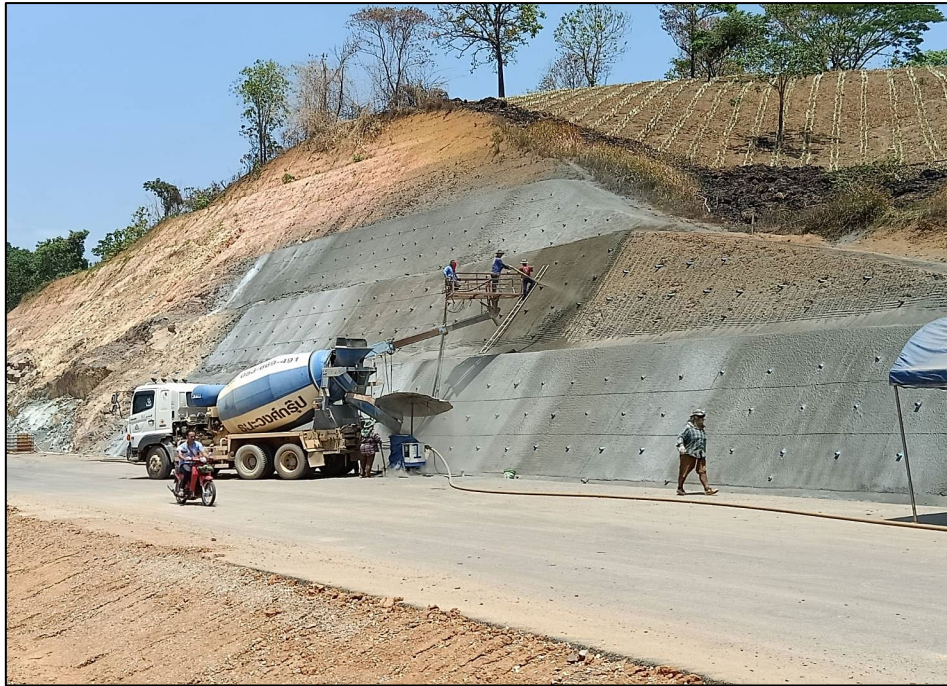
รูปที่ ๕๗ ฟันคอนกรีตชั้นที่ ๒
