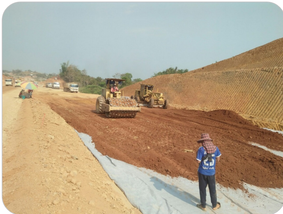
รูปที่ ๓๒ การบดอัดโครงสร้างชั้นทางหลังจากการบดอัดชั้นระบายน้ำ (Porous Layer)
