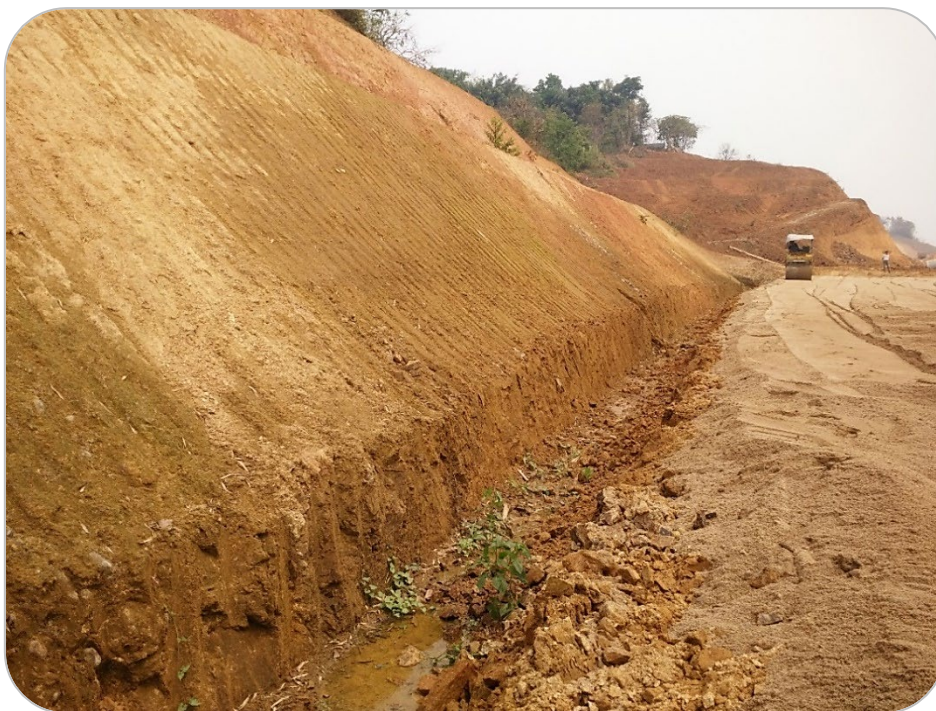
รูปที่ ๓๘ การขุดเปิดบริเวณปลายลาดดินตัดเพื่อก่อสร้าง SUBDRAIN
