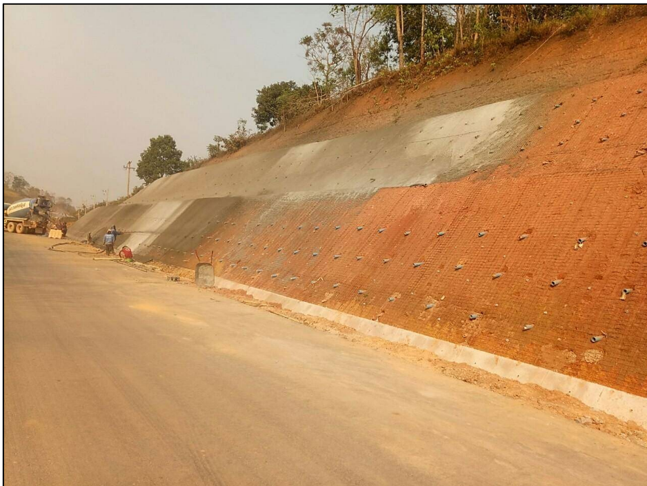
รูปที่ ๕๖ ติดตั้งตะแกรงเหล็ก และพ่นคอนกรีตชั้นที่ ๑
