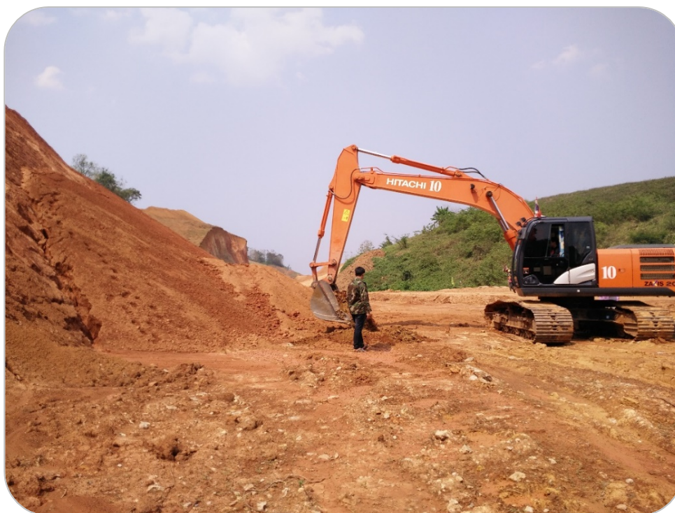
รูปที่ ๖ เก็บตัวอย่างวัสดุที่ระดับงานดินบริเวณ กม.๑๐+๕๒๕.๐๐๐ ไปทดสอบในห้องปฏิบัติการ
