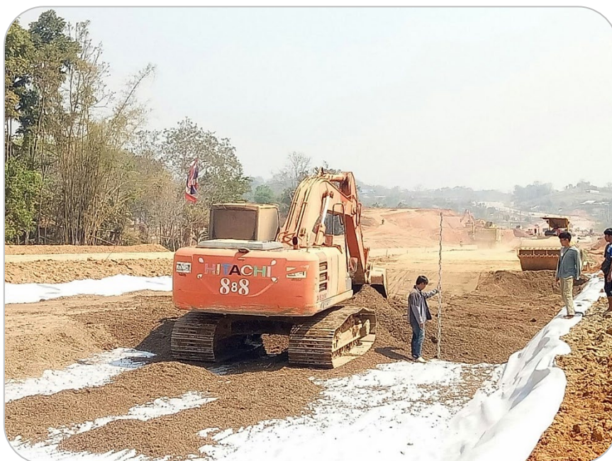
รูปที่ ๒๙ การลงวัสดุชั้นระบายน้ำ (Porous Layer)
