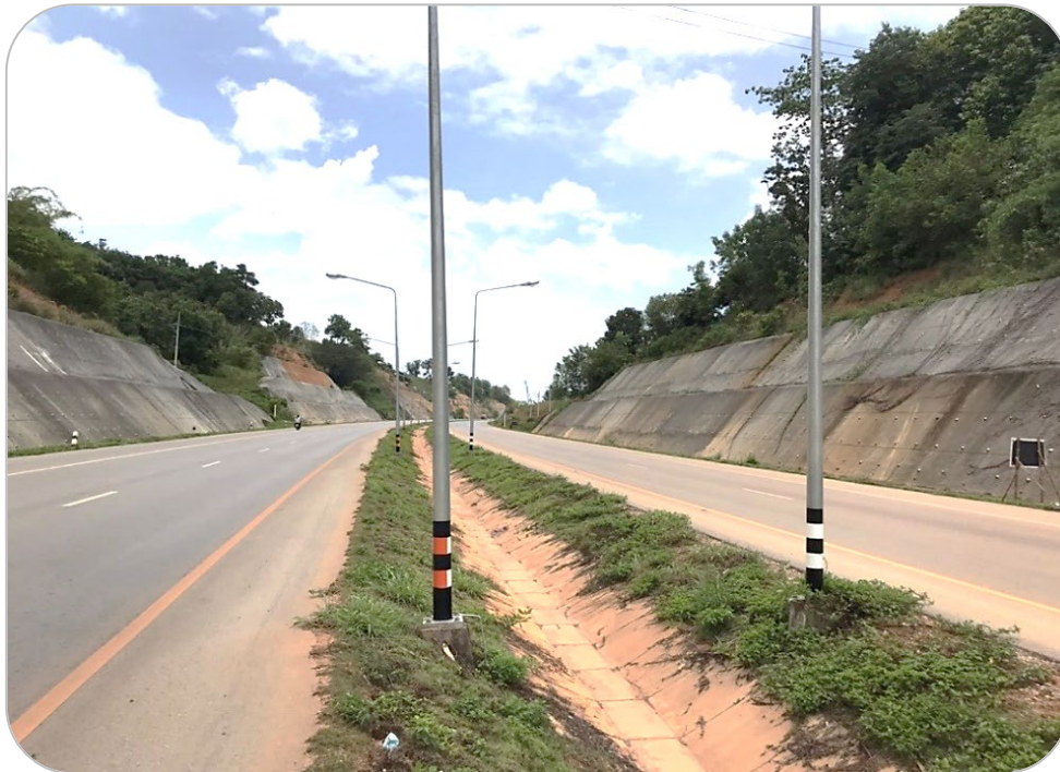
รูปที่ ๖๓ ถนนบริเวณ กม.๑๐+๔๐๐.๐๐๐ เมื่อวันที่ ๑๒ กันยายน ๒๕๖๕
