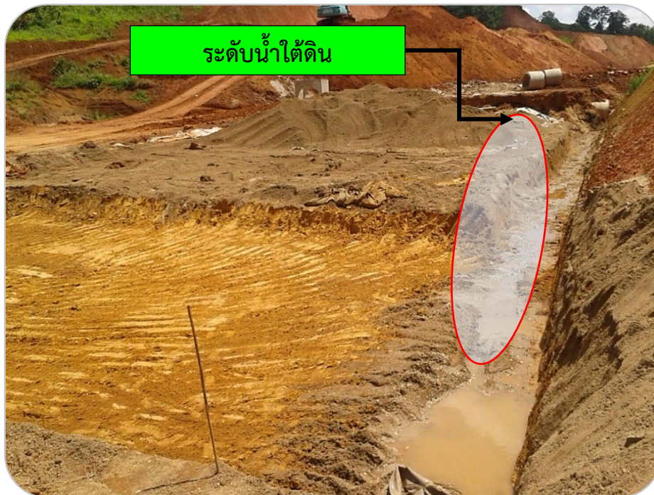
รูปที่ ๒๖ ขุดเปิดดินจนถึงระดับชั้นที่จะลงวัสดุระบายน้ำ (Porous Layer)
