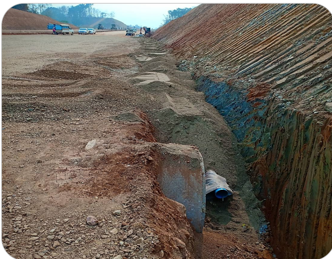
รูปที่ ๔๑ การติดตั้งท่อรับระบายน้ำและวัสดุที่ใช้ในการระบายน้ำ (Sub Drain)
