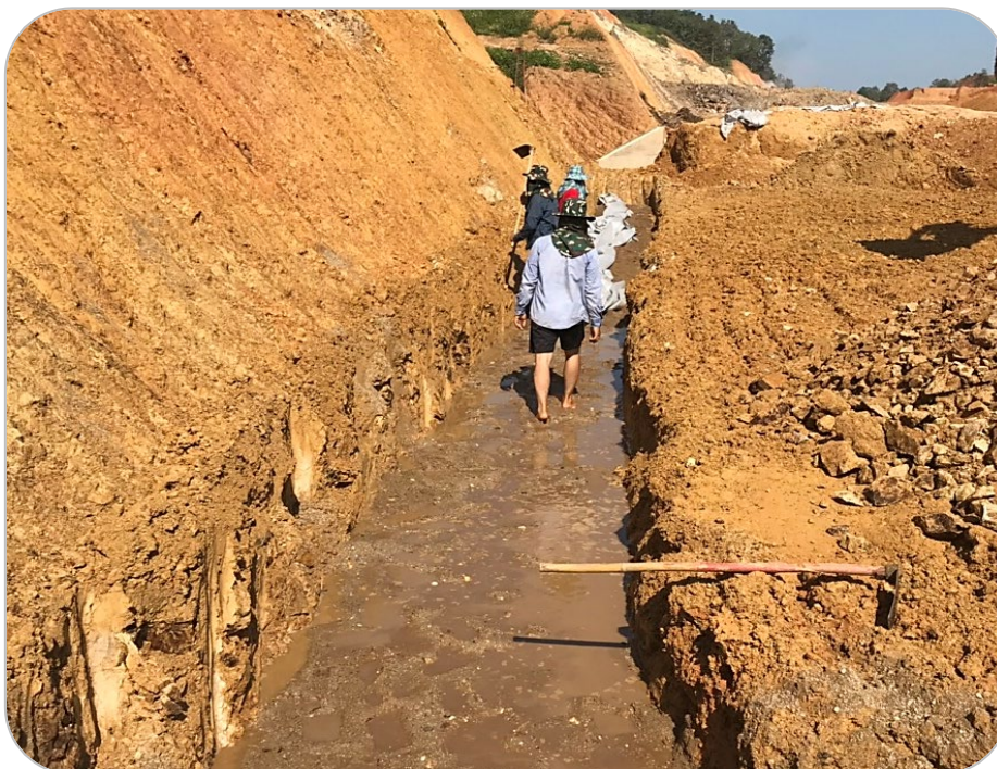
รูปที่ ๓๙ การขุดเปิดบริเวณปลายลาดดินตัดเพื่อก่อสร้าง SUBDRAIN
