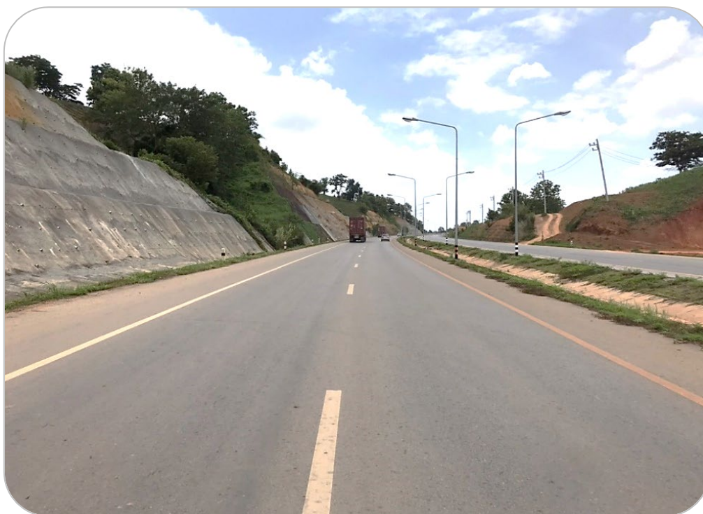
รูปที่ ๖๕ ถนนบริเวณ กม.๑๐+๖๐๐.๐๐๐ เมื่อวันที่ ๑๒ กันยายน ๒๕๖๕
