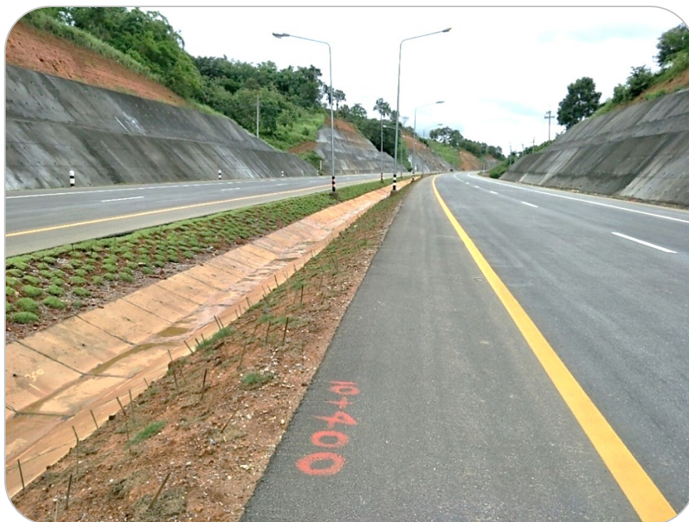
รูปที่ ๖๐ ถนนบริเวณ กม.๑๐+๔๐๐.๐๐๐ เมื่อก่อสร้างแล้วเสร็จ
