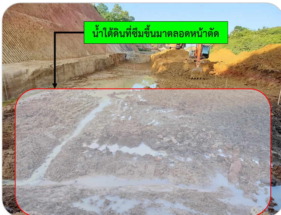
รูปที่ ๒๗ การไหลซึมของน้ำไต่ดิน
