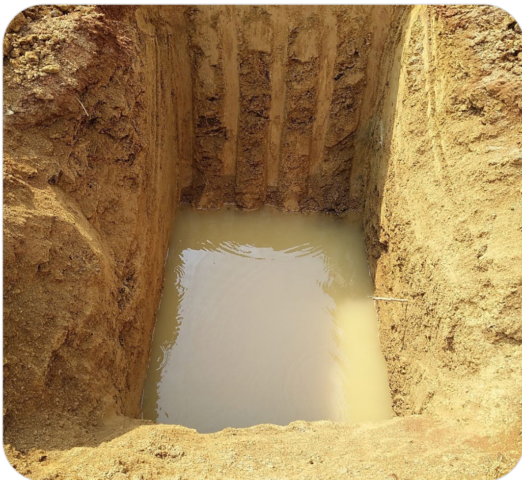
รูปที่ ๑๕ ระดับน้ำในบ่อสังเกตระดับน้ำหลังการขุดเปิดทิ้งไว้ ๗ วัน บริเวณ กม.๑๐+๘๐๐.๐๐
