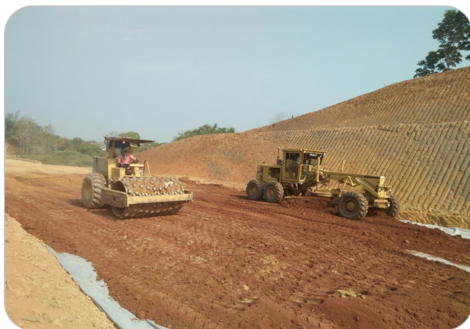
รูปที่ ๓๓ การบดอัดโครงสร้างชั้นทางหลังจากการบดอัดชั้นระบายน้ำ (Porous Layer)
