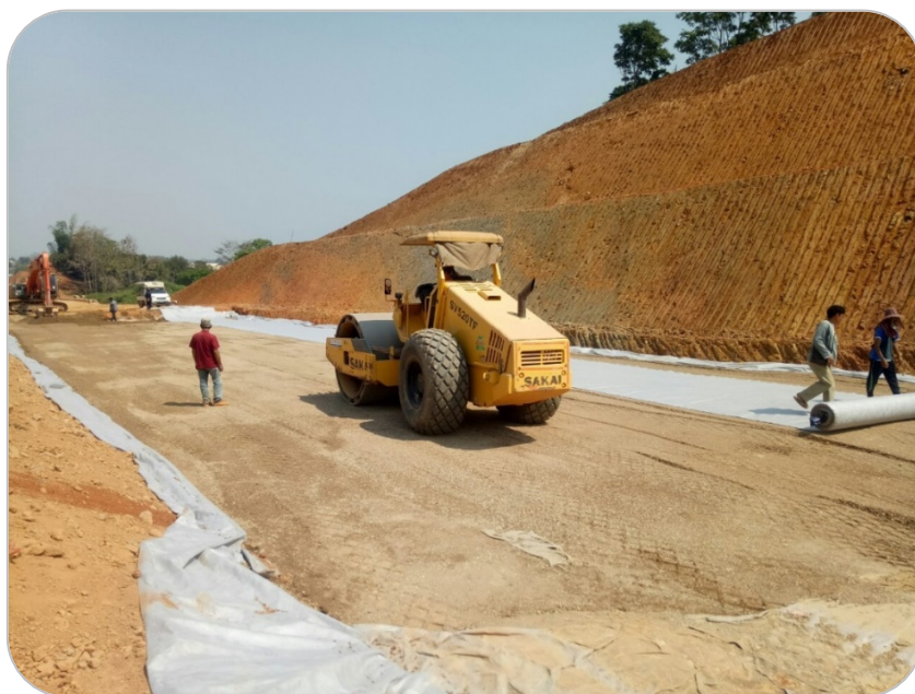
รูปที่ ๓๑ การปูวัสดุแผ่นใยสังเคราะห์ก่อนบดอัดโครงสร้างชั้นทาง
