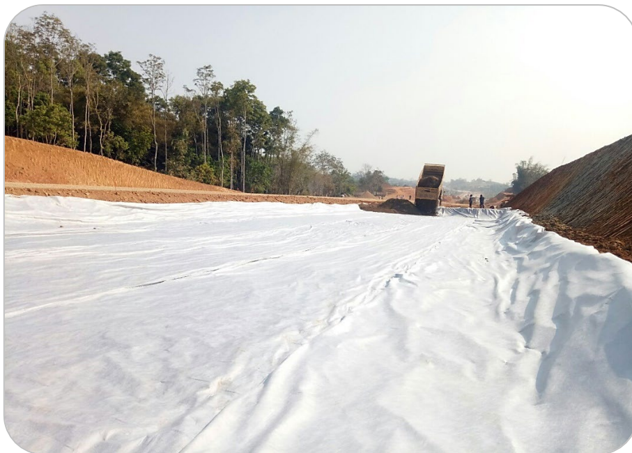
รูปที่ ๒๘ การปูแผ่นวัสดุโพลิเอทิลีนเพื่อแยกชั้นวัสดุ
