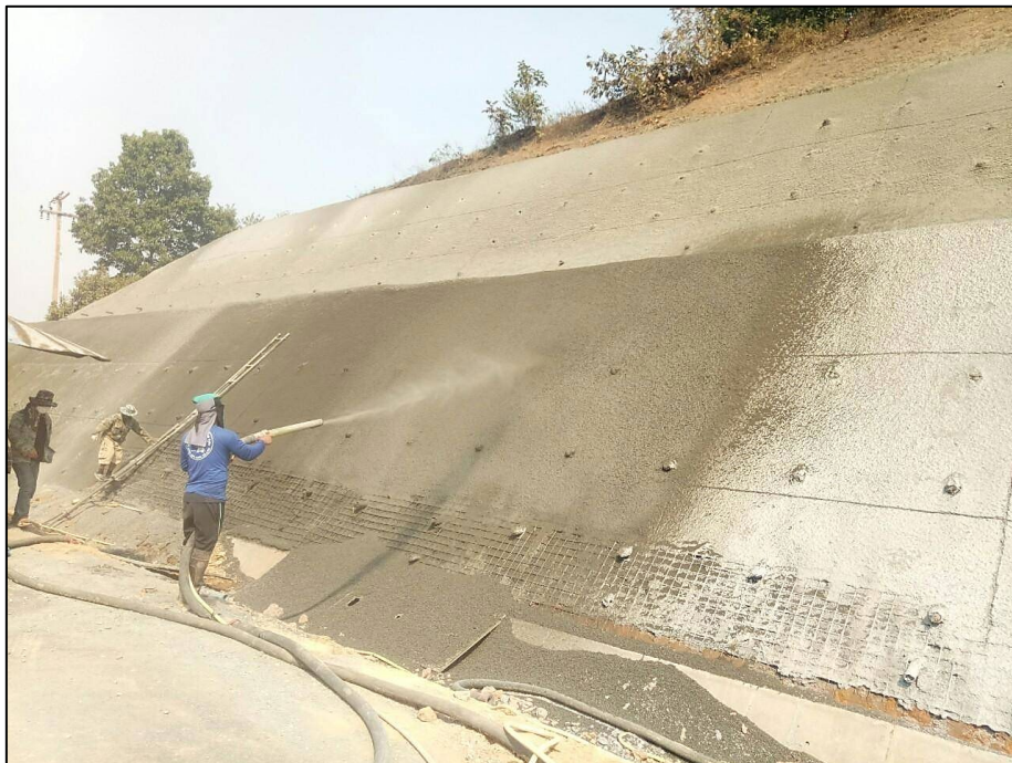
รูปที่ ๕๘ ฟันคอนกรีตชั้นที่ ๒
