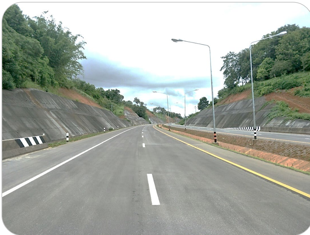
รูปที่ ๖๑ ถนนบริเวณ กม.๑๐+๖๐๐.๐๐๐ เมื่อก่อสร้างแล้วเสร็จ
