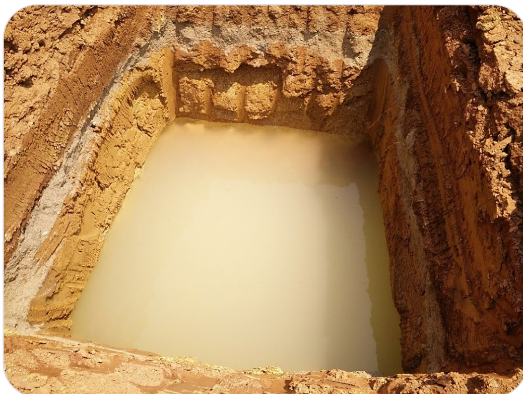
รูปที่ ๑๔ ระดับน้ำในบ่อสังเกตระดับน้ำหลังการขุดเปิดทิ้งไว้ ๗ วัน บริเวณ กม.๑๐+๔๐๐.๐๐
