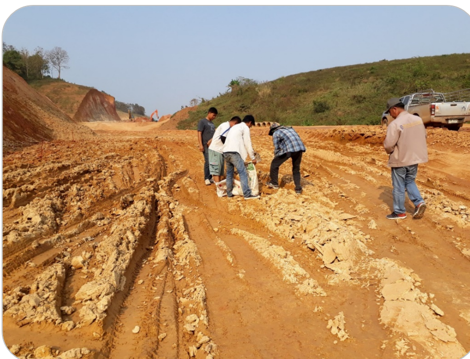
รูปที่ ๕ เก็บตัวอย่างวัสดุที่ระดับงานดินบริเวณ กม.๑๐+๔๘๐.๐๐๐ ไปทดสอบในห้องปฏิบัติการ
