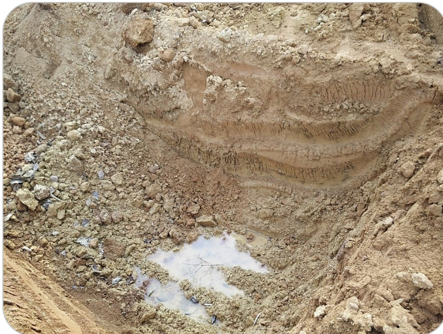
รูปที่ ๑๒ บ่อสังเกตระดับน้ำใต้ดิน กม.๑๐+๖๐๐.๐๐๐
