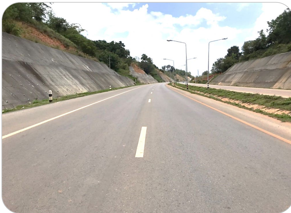
รูปที่ ๖๔ ถนนบริเวณ กม.๑๐+๔๐๐.๐๐๐ เมื่อวันที่ ๑๒ กันยายน ๒๕๖๕
