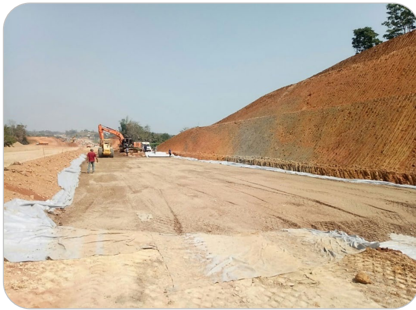
รูปที่ ๓๐ การบดอัดวัสดุชั้นระบายน้ำ (Porous Layer)
